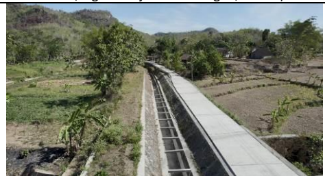
Rehabilitasi Jaringan Irigasi D.I. Payaman (DAK)
