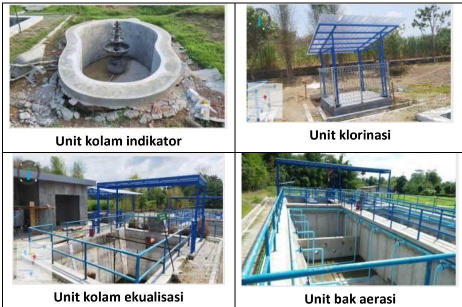
Gambar III.2 Peningkatan Kapasitas IPLT Madurejo Kabupaten Sleman
